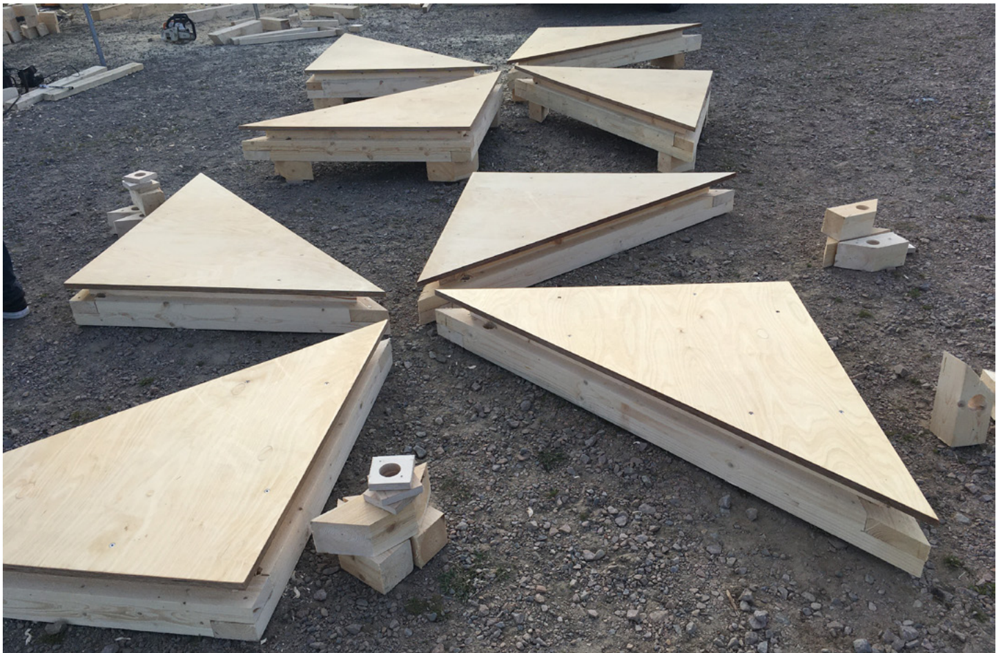
Dansbanan - modulär och flyttbar. Här under konstruktion 5 sept 2020. Foto Anna Asplind
